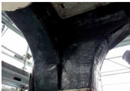
Rinforzo volte in muratura con fibra di carbonio C-Sheet e connettori GFRP in vetro e SFRP in acciaio Civita di Bagno (Aq) - Edificio privato
