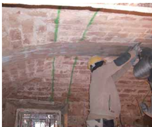
Cantiere aggregato di Via Roma all'Aquila Rinforzo di murature e volte con tessuto in fibra di acciaio galvanizzato STEEL NET G 220, malta a base calce LIMECRETE e connettori in acciaio SFIX G.
