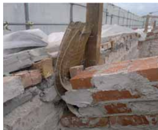
Cordolo di sommità rinforzato con tessuto in fibra di acciaio STEEL NET G220 e malta a base calce LIMECRETE.
