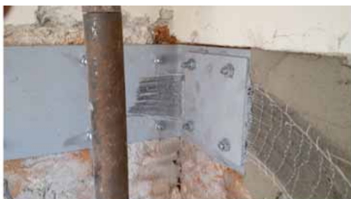
Cantiere Villa Comunale Porta Napoli (AQ) Rinforzo di murature con tessuto in fibra di acciaio inox STEEL NET I304 pretensionato.
