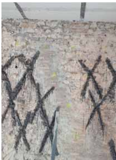
Cantiere Palazzo Signorini-Corsi (AQ) Connettori passanti AFIX con adesivo Resin 75.
