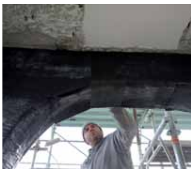
Rinforzo volte in muratura con fibra di carbonio C-Sheet e connettori GFRP in vetro e SFRP in acciaio Civita di Bagno (Aq) - Edificio privato
