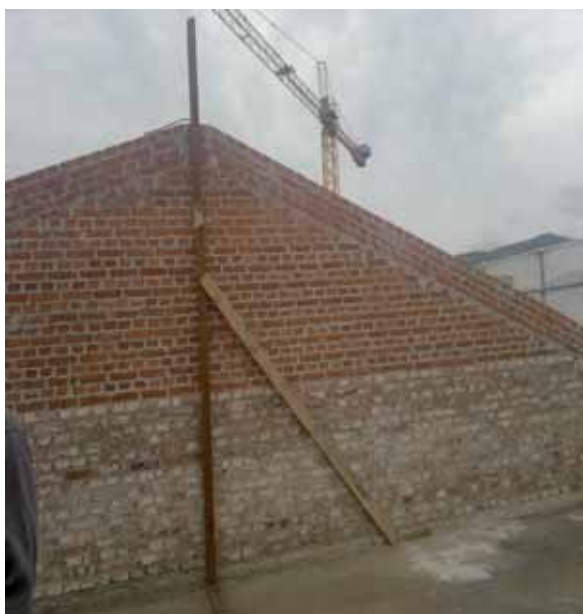
Cordolo di sommità rinforzato con tessuto in fibra di acciaio STEEL NET G220 e malta a base calce LIMECRETE.
