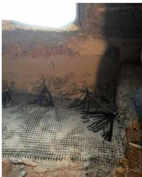
Cantiere Istituto Apostole S. Cuore di Gesù, Avezzano (AQ) Rinforzo di murature, setti, pilastri con rete in fibra di carbonio C-NET, connettori in aramide AFIX e malta CONCRETE ROCK S.
