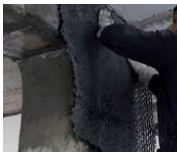
Rinforzo pilastri e nodi c.a. con fibra di carbonio quadriassiale C-Sheet Gignano (Aq) - Edificio privato
