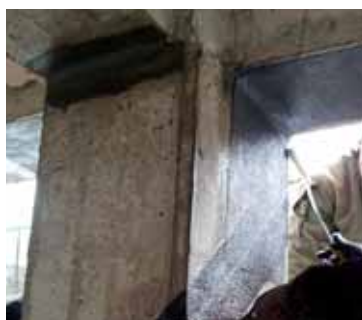
Rinforzo nodi e pilastri c.a. con fibra di carbonio bidirezionale CTB e quadriassiale C-Sheet L'Aquila - Condomini
