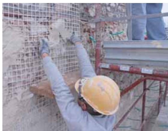
Cantiere di Roio Poggio e Roio al Piano (AQ) Rinforzo di volte e murature con rete in fibra di vetro AR G-NET 301 BAL, connettori in vetro GFIX AR e matrice inorganica.
