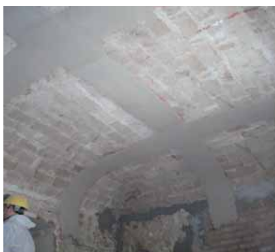
Cantiere aggregato di Via Roma all'Aquila Rinforzo di murature e volte con tessuto in fibra di acciaio galvanizzato STEEL NET G 220, malta a base calce LIMECRETE e connettori in acciaio SFIX G.
