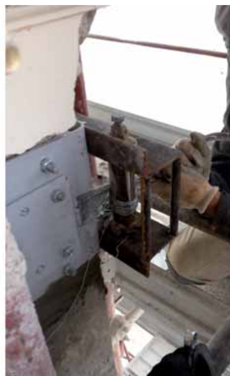
Cantiere aggregato di Via Roma all'Aquila Rinforzo di murature e volte con tessuto in fibra di acciaio galvanizzato STEEL NET G 220, malta a base calce LIMECRETE e connettori in acciaio SFIX G.
