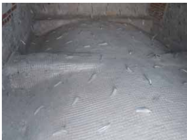
Cantiere di Roio Poggio e Roio al Piano (AQ) Rinforzo di volte e murature con rete in fibra di vetro AR G-NET 301 BAL, connettori in vetro GFIX AR e matrice inorganica.
