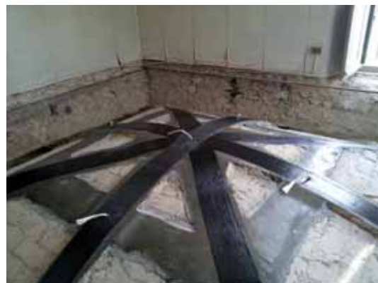
Rinforzo volte in muratura con fibra di carbonio C-Sheet e connettori GFRP in vetro Castel di Ieri (Aq) - Aggregato privato
