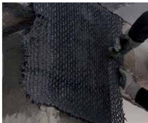
Rinforzo pilastri e nodi c.a. con fibra di carbonio quadriassiale C-Sheet Gignano (Aq) - Edificio privato
