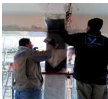
Rinforzo nodi e pilastri c.a. con fibra di carbonio bidirezionale CTB e quadriassiale C-Sheet L'Aquila - Condomini
