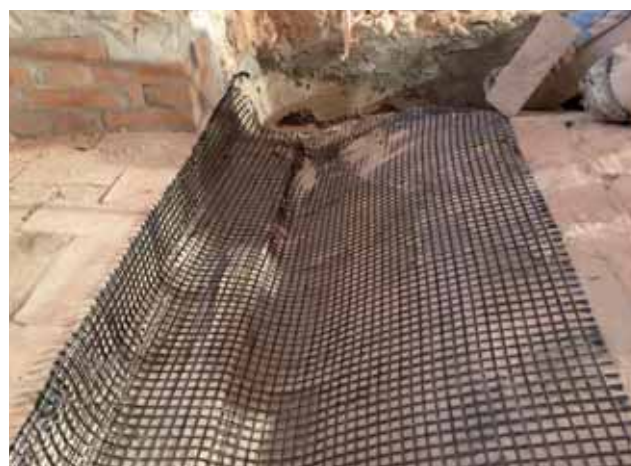
Cantiere Palazzo Chiarino (AQ) Rinforzo di volte con rete in carbonio C-NET, connettore CFIX e malta in calce naturale LIMECRETE.
